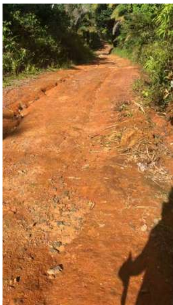
Estrada vicinal sem asfalto Fonte: visita técnica 09/03/2022
