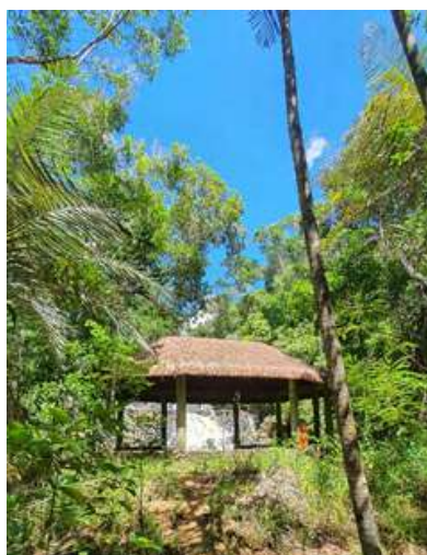
Quiosque para apreciação a vista da cachoeira Fonte: visita técnica 19/05/2022
